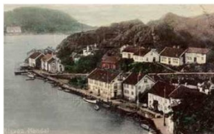
Slik så Kleven ut omkring år 1900. Byggene i forgrunnen er revet, men tilnærmet identiske kan bli bygget opp igjen i den gamle uthavnen. FOTO: PRIVAT POSTKORT
